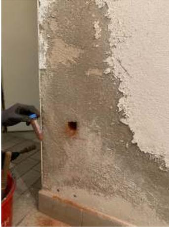
Probenentnahme zur Feuchtigkeitsanalyse
